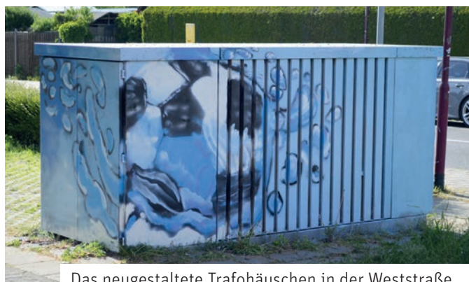
Das neugestaltete Traföhäuschen in der Weststraße
